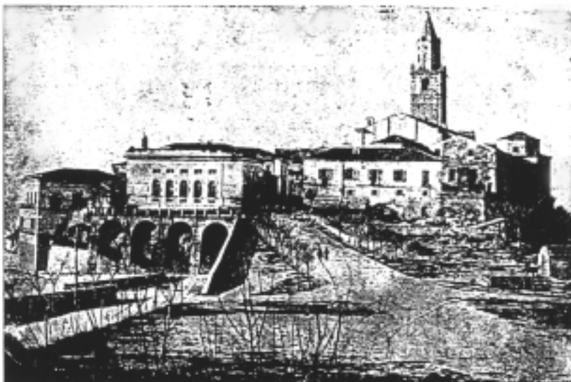
Città S. Angelo: Istituto Magistrale in costruzione (1884)
