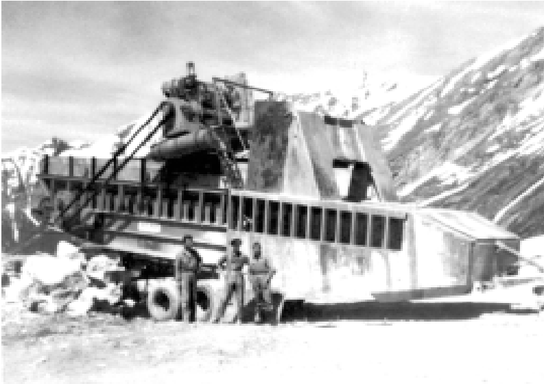
Machina per triturare la roccia scavata. Il materiale veniva poi caricato sui camion.
